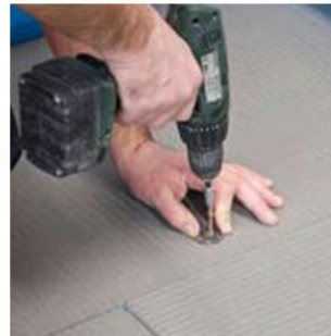
Pritvirtinkite plokštes - Tvirtinimo detalėmis (ant betoninio pagrindo) - Sraigtais su tarpine (ant medinio pagrindo).
