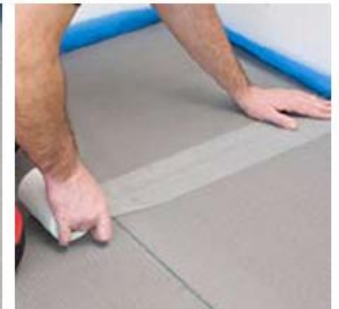
Ant plokščių sujungimų užklijuokite Isolecta juostą (kitą dieną).
