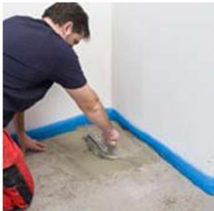
Plokštėms priklijuoti prie pagrindo naudokite plytelių klijus.
