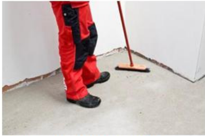
Išvalykite pagrindą nuo dulkių ir purvo
