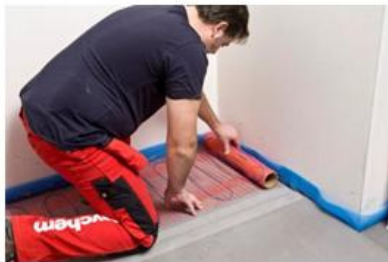
Pagal T2QuickNet montavimo instrukciją paklokite šildymo kilimėlį.
